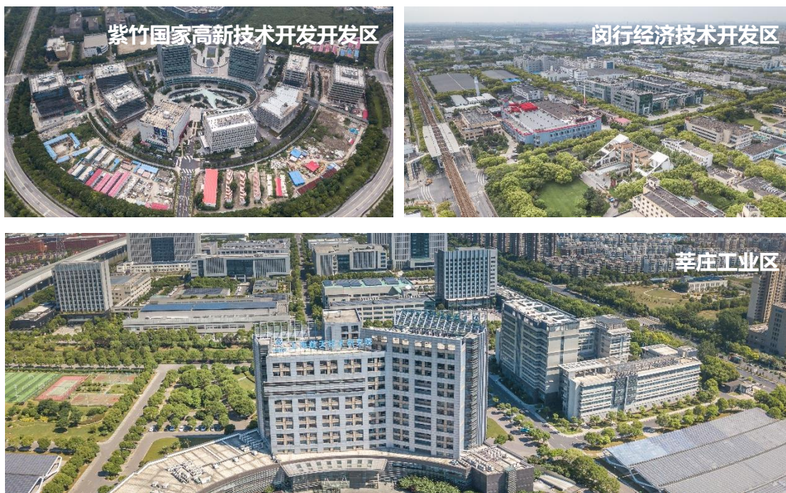
产业园区现状照片
