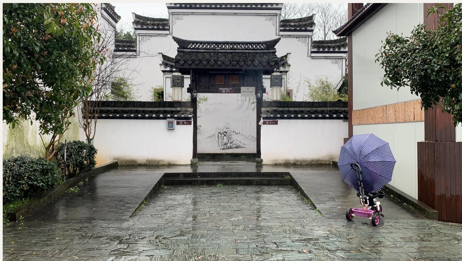
图 -浙江某村庄住宅楼出入口坡道
