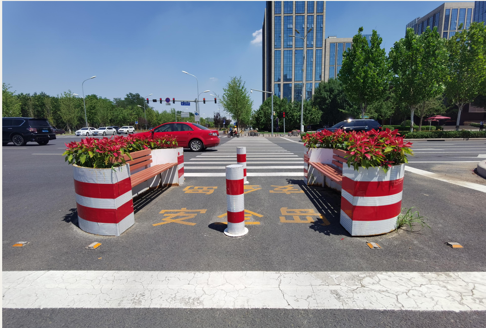
图 - 北京市通州区经济开发区过街安全岛
