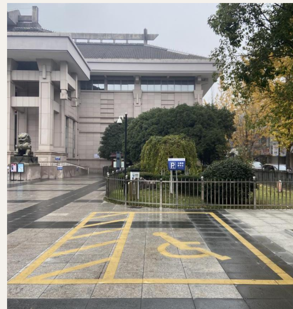
图：大型博览建筑无障碍停车位
