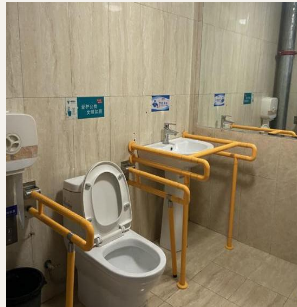
图：大型博览建筑无障碍卫生间
