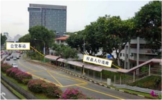
图 11-7 新加坡公交站有盖人行连廊
