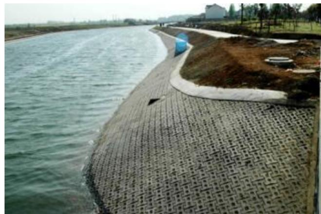
图 10-27 铰接式砼块护坡
