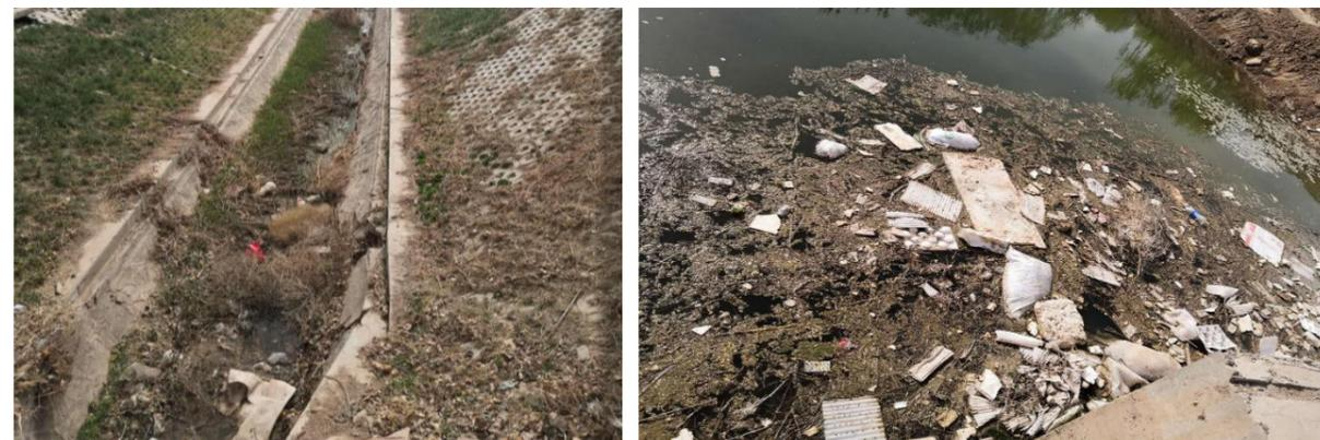
图 4-35 局部河道及岸线缺少维护（存在垃圾和漂浮物）
