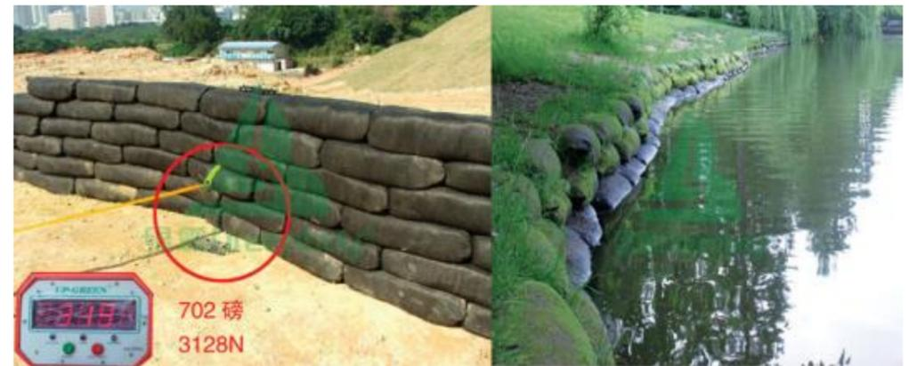
图 10-26 生态袋挡墙断面
