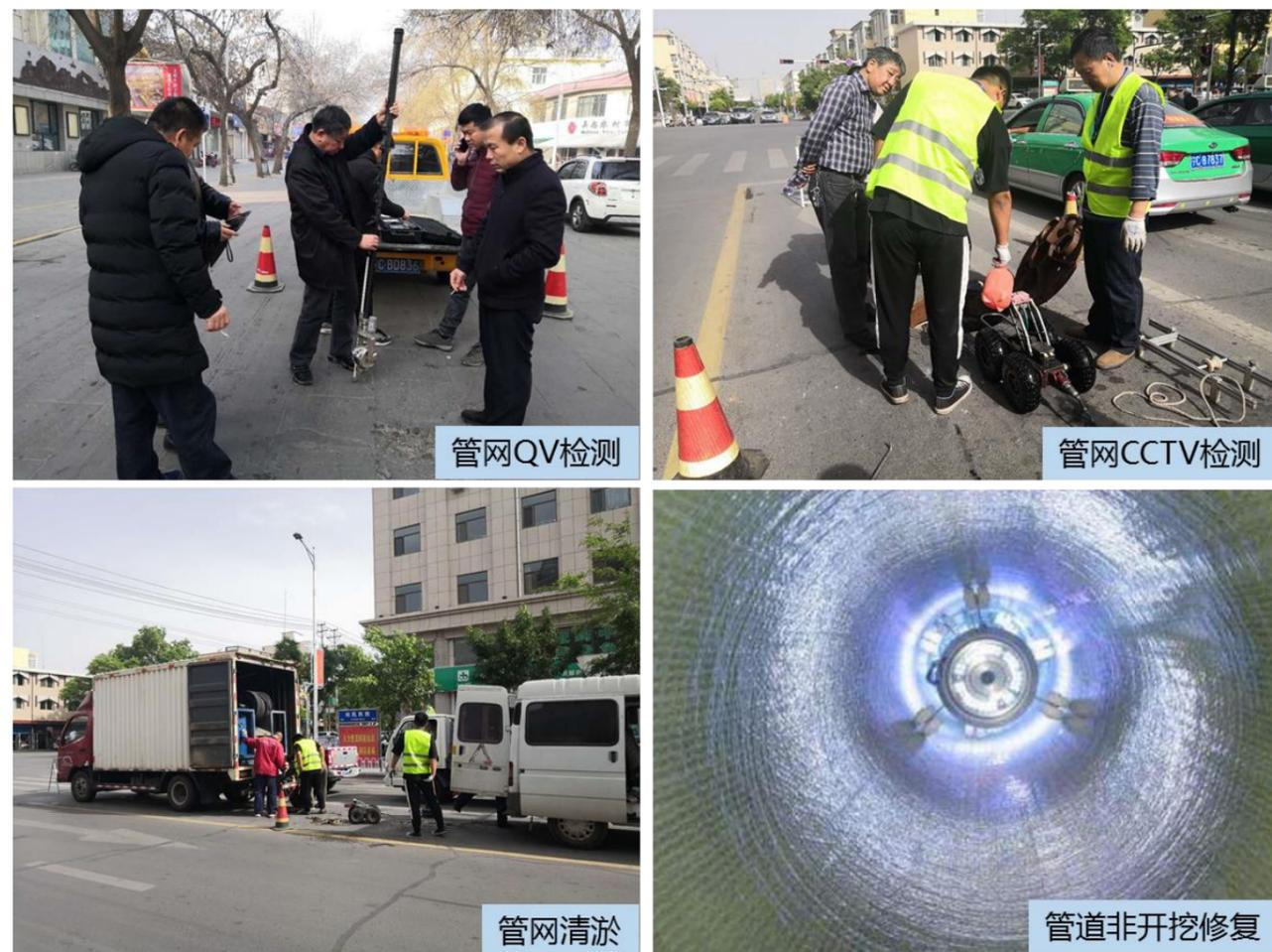
图 7-13 管网诊断与修复
