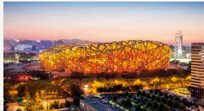
国家体育场特色照明（全景网提供） Lighting on Beijing National Stadium 在节庆、重要赛事等特殊时间，通过变换建筑物夜景灯光色彩烘托氛围。
