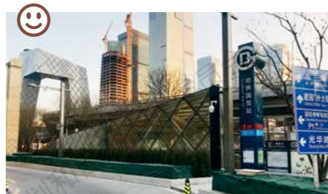
国贸站 E 口 (郭婧摄) Exit E of Guomao Station 简洁的站口设计与周边建筑风格十分匹配。
