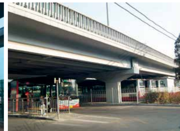
桥下空间作为公交场站（王玥宸摄） Bus stops under bridges
