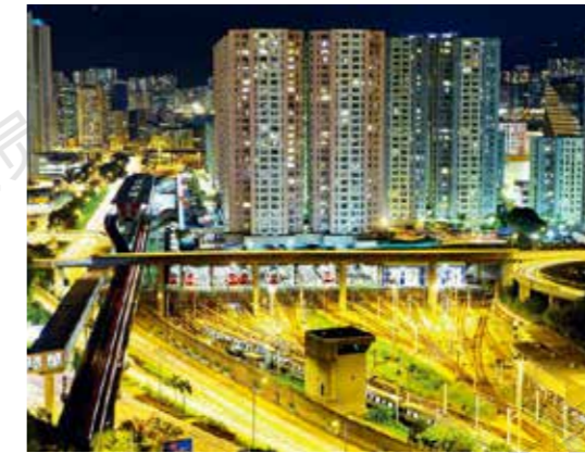
九龙站空中连桥（全景网提供） Kowloon Station aerial bridge
