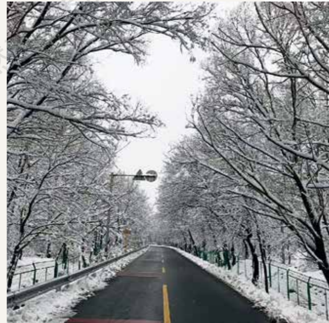
延庆山区公路（刘友晨提供） Yanqing mountainous highway
