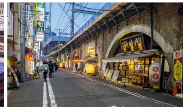
日本东京新桥桥下空间（全景网提供） Space under the bridge of The new bridge Minato-ku Tokyo Japan 高架桥下区域变身艺术文化与休闲餐饮区。
