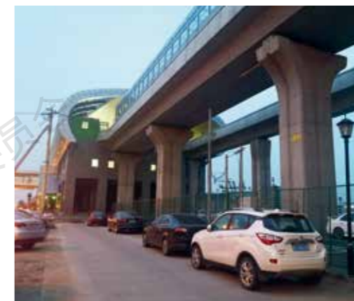
桥下空间作为停车场对公众开放（辛萍摄） Parking spaces under bridges open to the public
