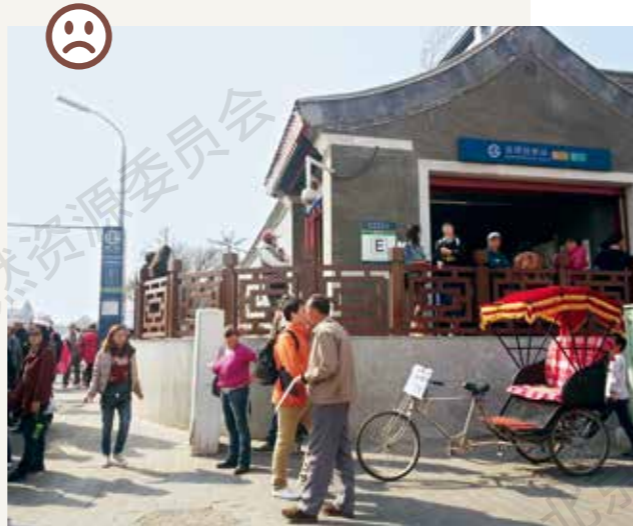
南锣鼓巷站 E 口（辛萍摄） Exit E of Nanluogu Alley Station 出站口与街道间有较大高差，出站乘客拥挤在有限的出站口平台上，不利于安全疏散。
