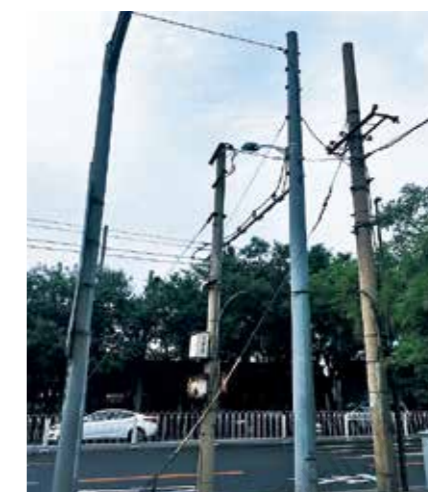
改造前（王京京摄） Before renovation
