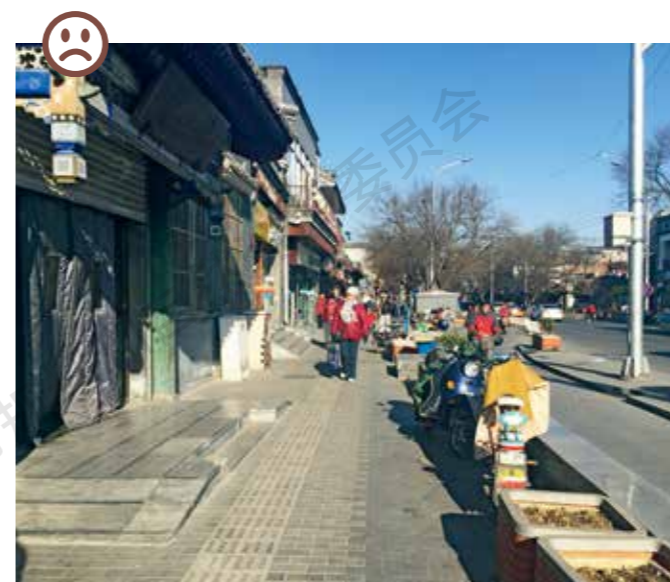
地安门外大街（郭婧摄） Di'anmen Outer Street 商铺台阶侵占行人通行空间。
