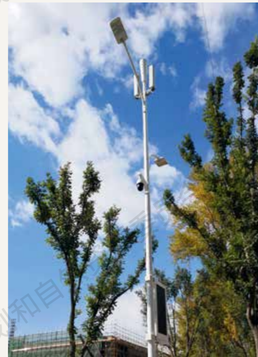
集合综合功能的智慧灯杆，集约利用空间，包含：通信基站、主路照明、辅路照明、治安监控、多功能显示屏。（中国移动提供）
