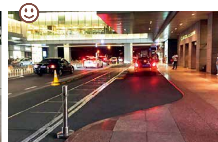
金桐东路，国贸商城一期（郭婧摄） East Jintong Road, Phase I of International Trade Mall 合理设置落客港湾实现人车分流。
