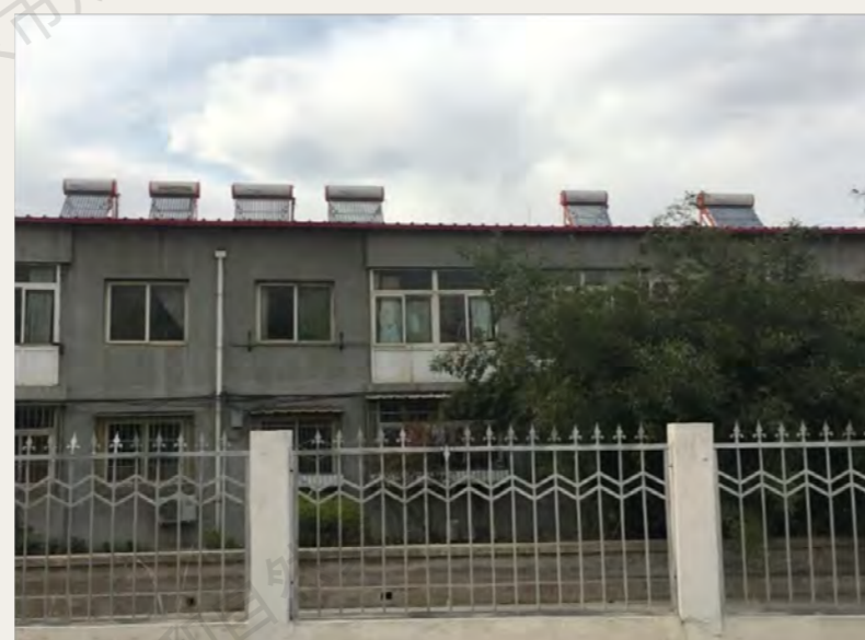
高出女儿墙的屋顶设施
