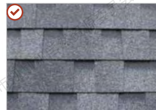
其他建筑屋面材料采用灰色玻纤瓦
