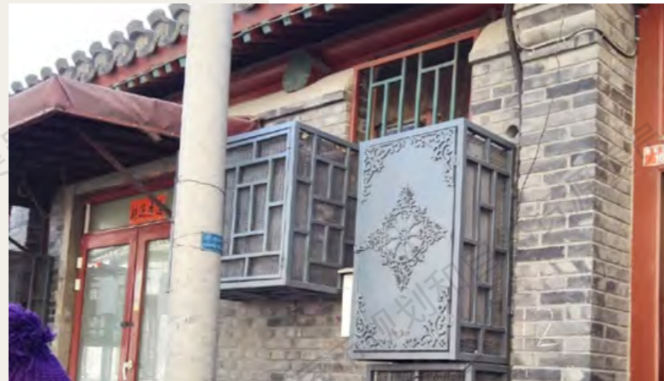
空调室外机、电箱外罩隐蔽处理
