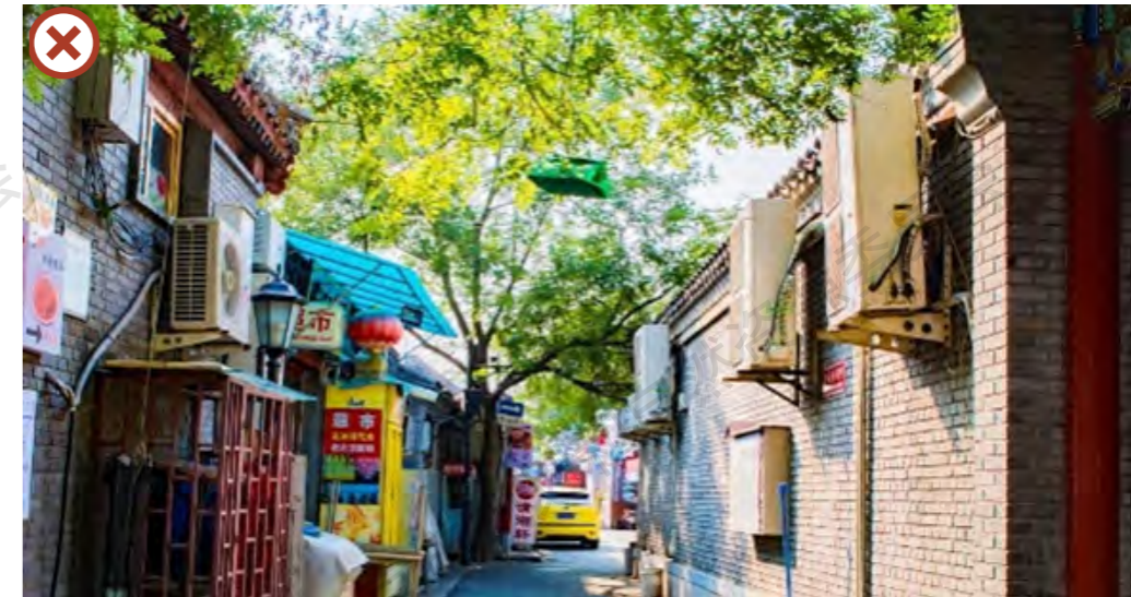
各类建筑外挂设施设置杂乱
