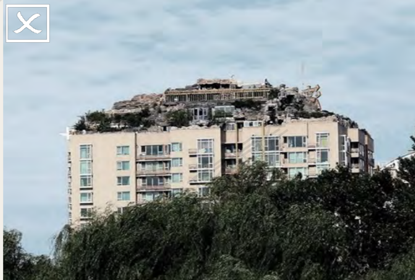
人济山庄屋顶的屋顶违建
