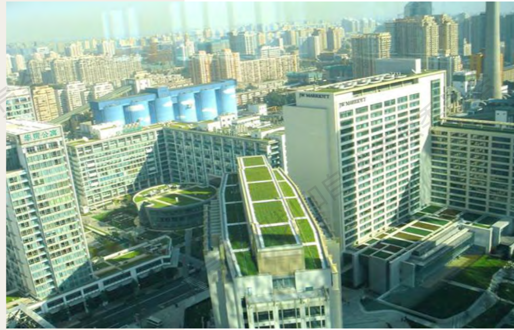
朝阳区华贸中心屋顶草坪
