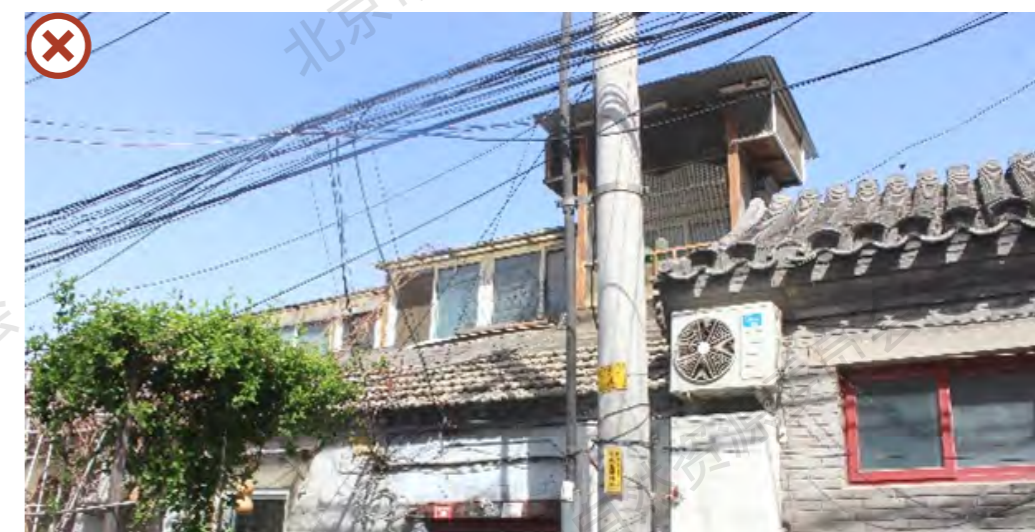
违规加建二层、破坏传统屋顶轮廓
