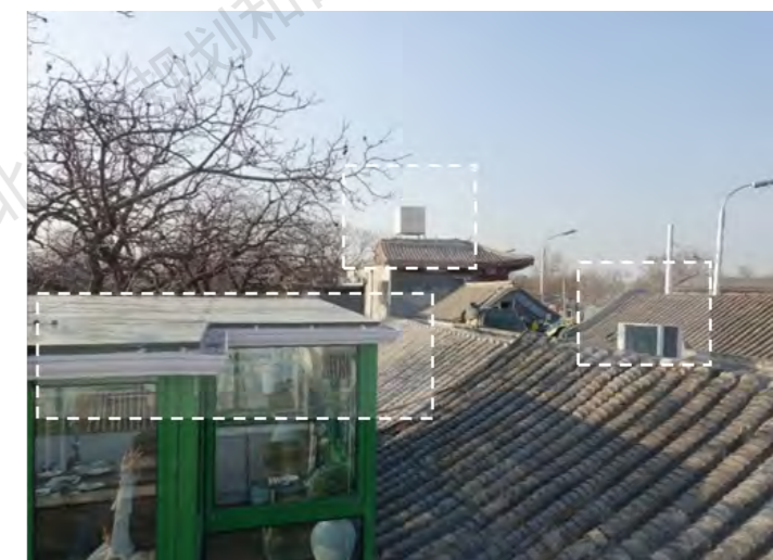
加强建筑屋顶设施管控
