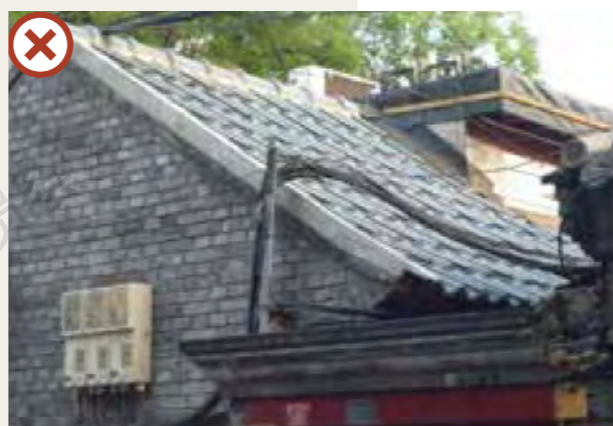
传统风貌建筑屋面采用平机瓦
