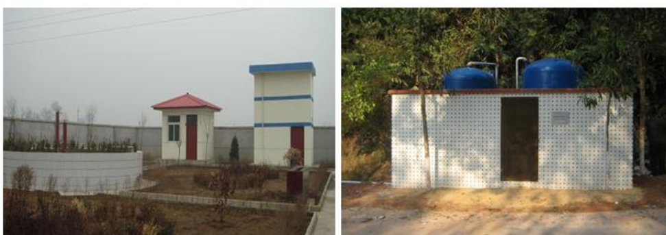
图18 农村安全饮水工程
