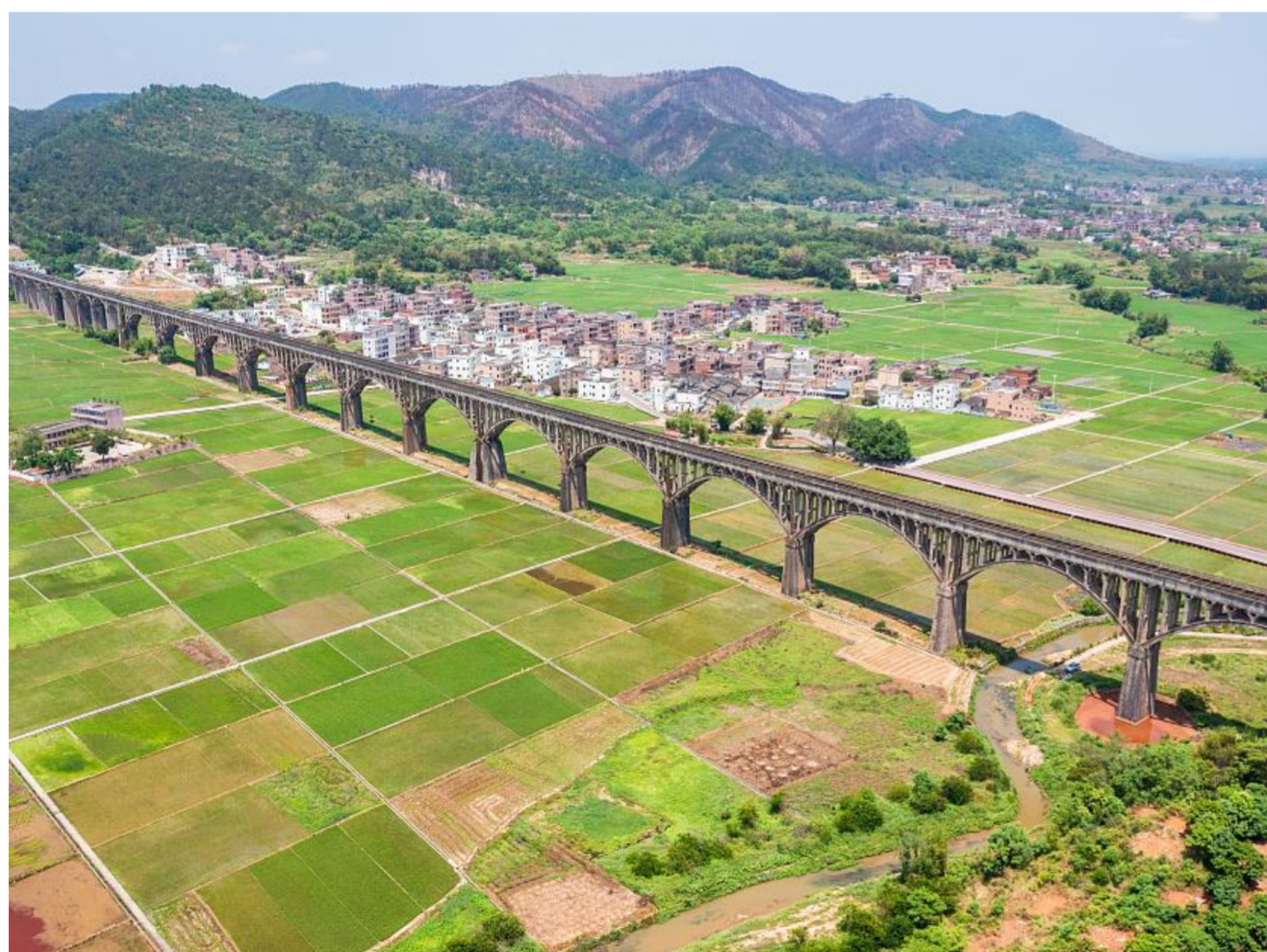
国家级文物保护单位：长岗坡渡槽
