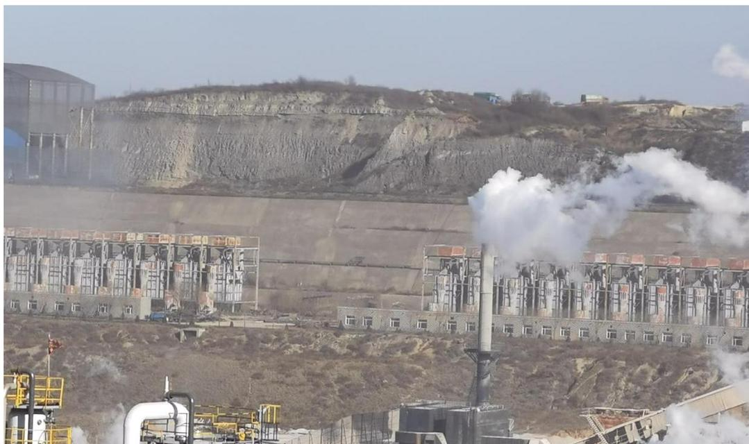
照片3-19 正能化工厂区内北侧切坡（存在崩塌）
