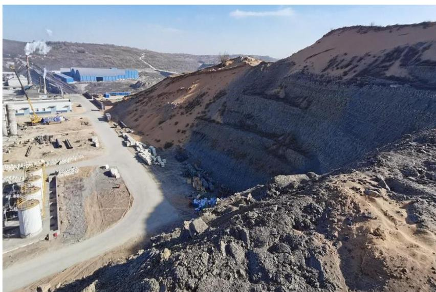
照片3-16 信诺正能在建项目场地西侧南侧切坡崩塌
