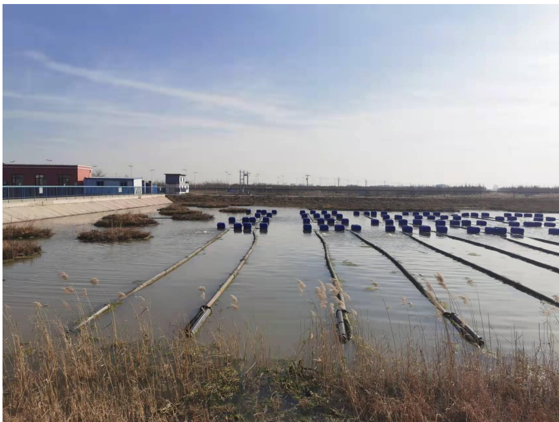
图 3.5-2 石碑河（中捷段）生态治理与生态修复一期工程现场图
