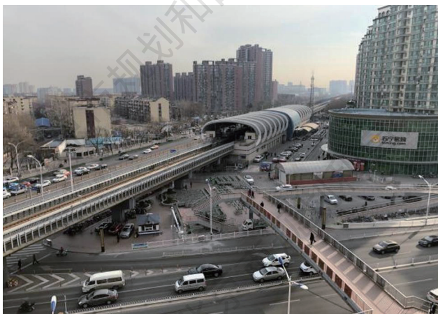
/ 地铁站周边现状
