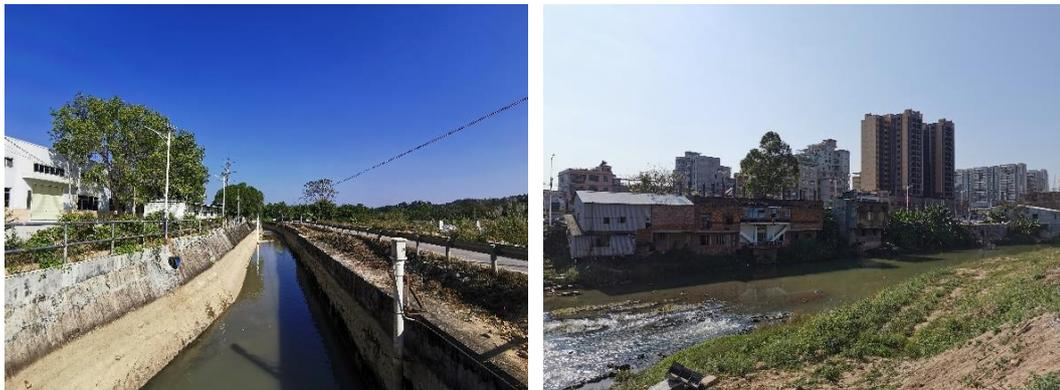
图 6.7-7 现状龙平渠硬质护岸和白沙河段水岸堤内建筑
