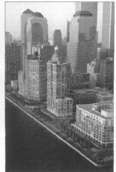
图5 沿河建筑组群景观
