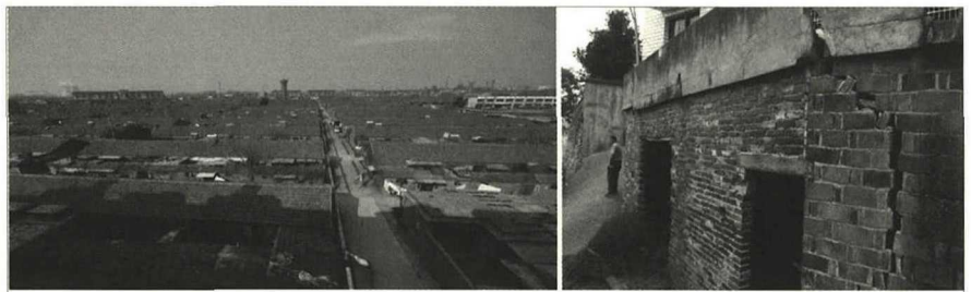
图2 贾汪区旧貌 权台矿工人村 地面塌陷造成的房屋开裂
