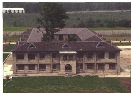
图7 改造后的韩桥煤矿
