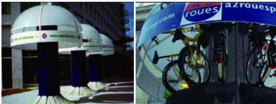
图 15 方便的路边非机动车停车设施
