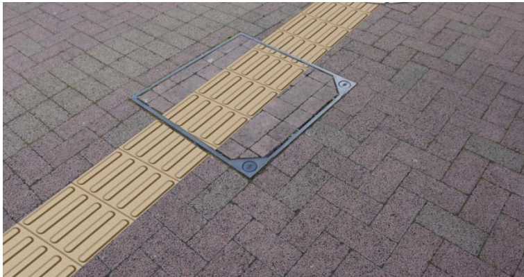
图4-37 盲道不用绕行检查井盖
