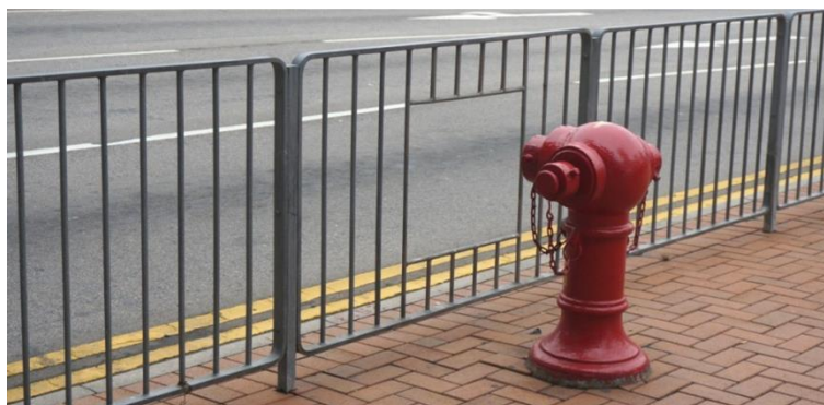
图7-18 路侧护栏开口实景图
