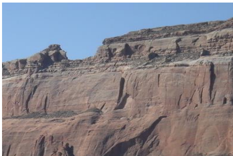
图7-5 稳定岩石边坡裸露岩面图
