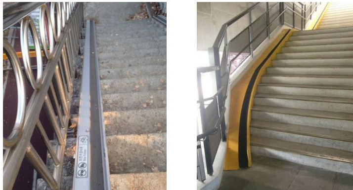
图4-29 设有半圆形凹槽的自行车推行坡道
