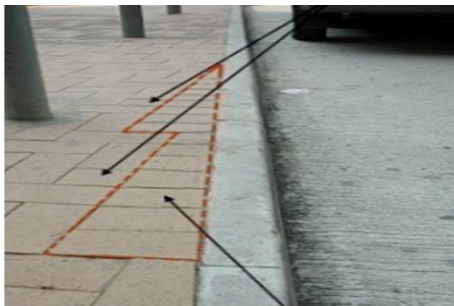
图4-13 人行道边角铺装细节处理
