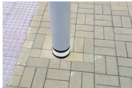
图4-14 人行道与构造物衔接处铺装细节处理
