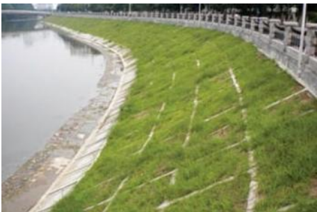
图 7-3 植生型生态混凝土护坡
