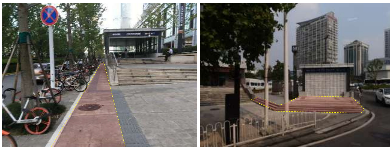
武汉市，地铁站口人行道狭窄，部分站点缺乏无障碍设施
