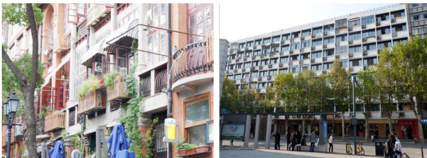
黎黄陂路空调外机隐蔽化处理效果
