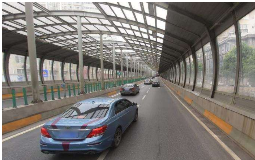
高架道路隔音屏障
