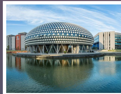
□ 苏州国际科技园
