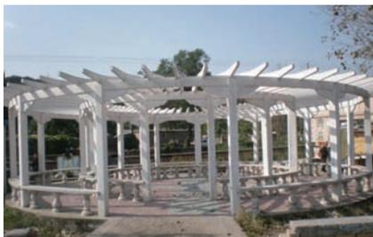
钢筋混凝土结构花架
