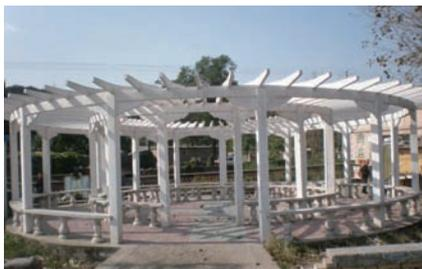
钢筋混凝土结构花架
