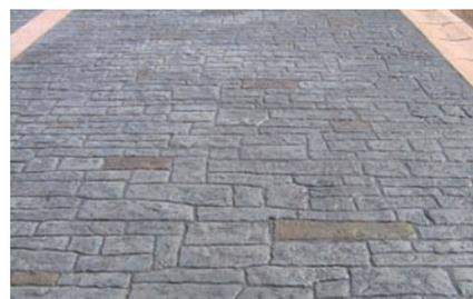
混凝土压膜纹样
