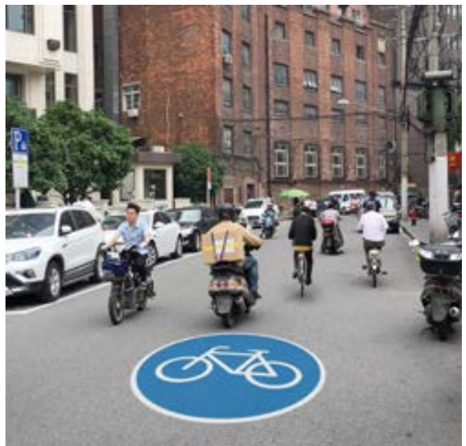
非机动车道路： 在地面增加标识，提示机动车礼让非机动车
