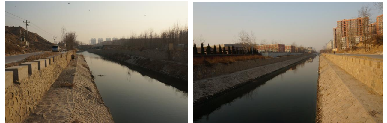
图 5.3-6 五支渠排水防涝保障段现状图
