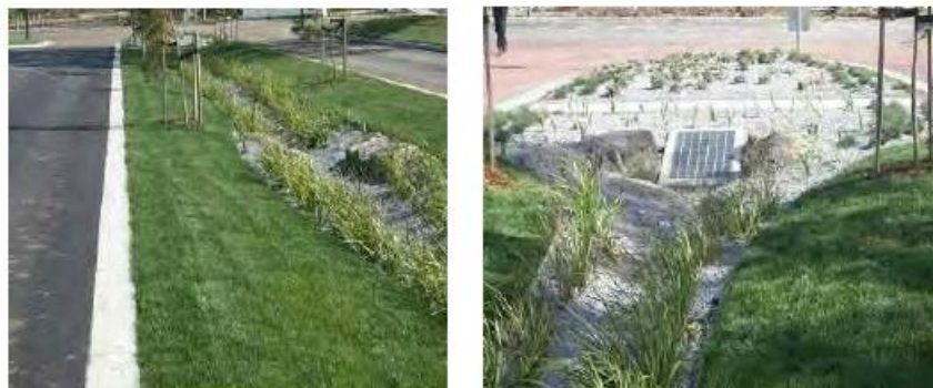
图 4-4 林恩布鲁克房地产的生物过滤系统
