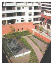
图 4-7 利用雨水灌溉屋顶花园
