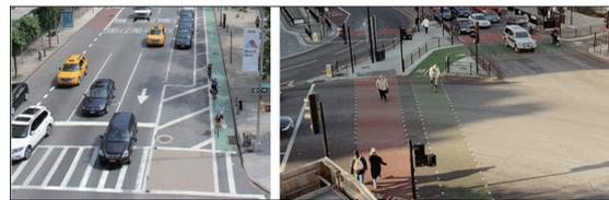
图19 交叉口机动车停车线后退，过街设置人行道和自行车道的安全岛（纽约自行车道设计）
