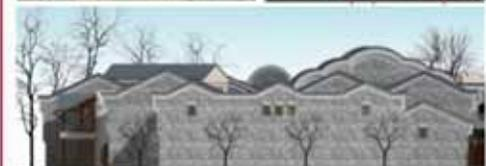
构造层次清晰的立面的勒脚、墙身、檐下、屋面，山墙主要的形式有阶梯型、山行（三角形）、拱形、组合型等。武汉传统民居的屋面多为双坡硬山，山墙、墙头一般不出屋面，保持屋面防水体系的完整性。
