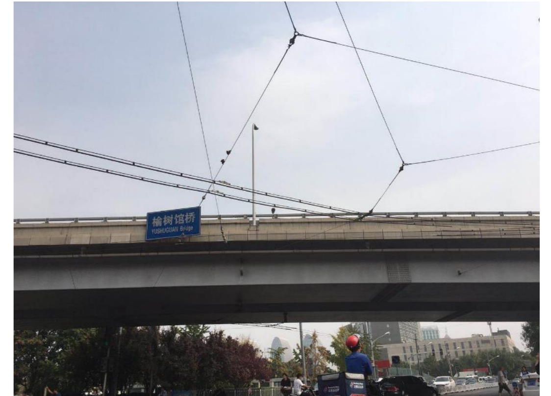
北京道路上空的架空线路
