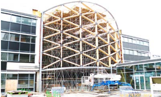
Construction of « The Base », Schiphol Airport © buitlingstaalbouw.nl
