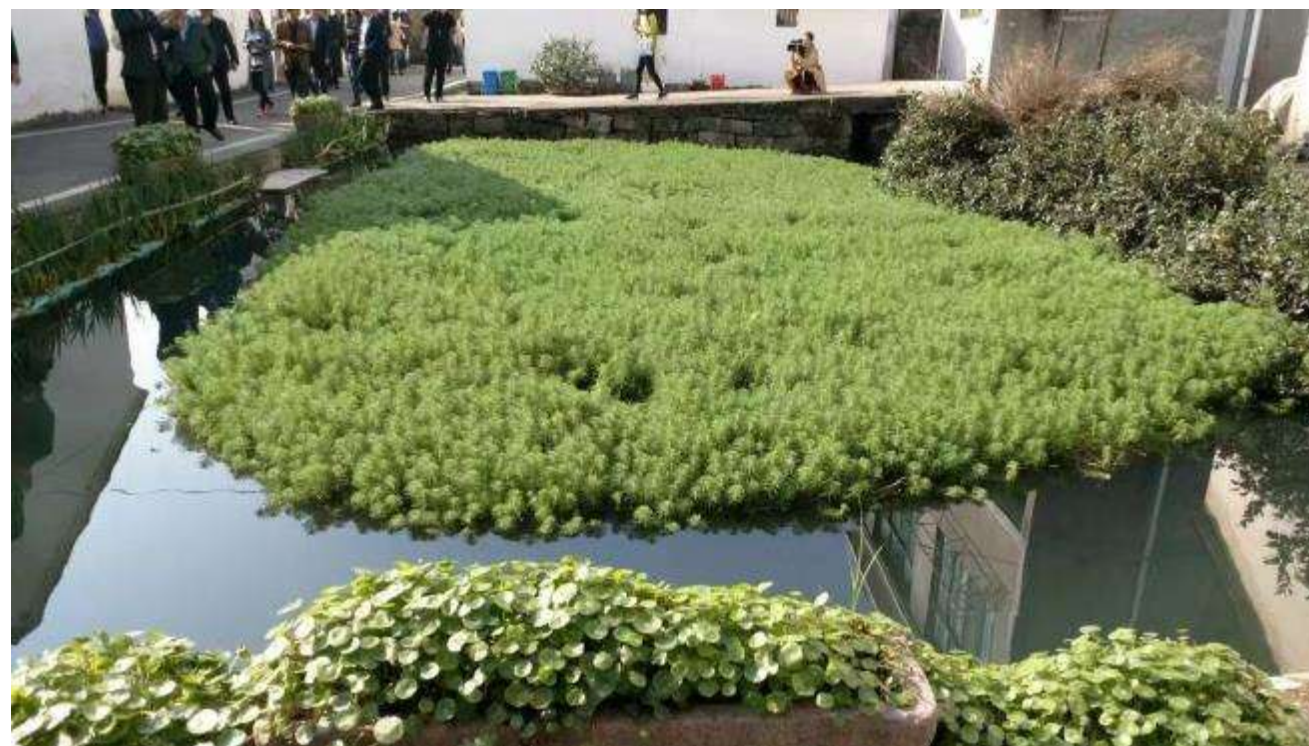
景观化处理的污水净化池
