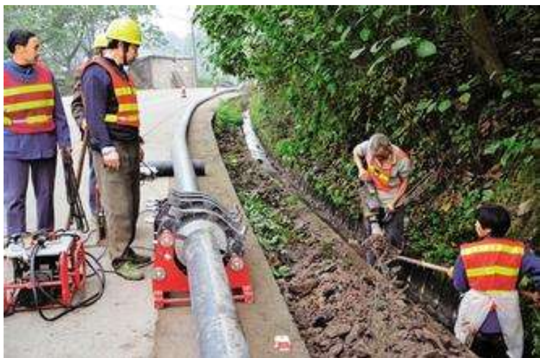
村内污水管道
