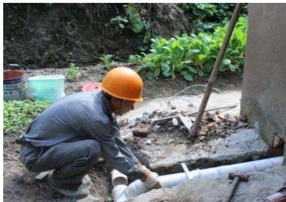
村内污水管道
