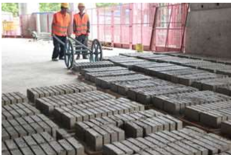
建筑垃圾回收
