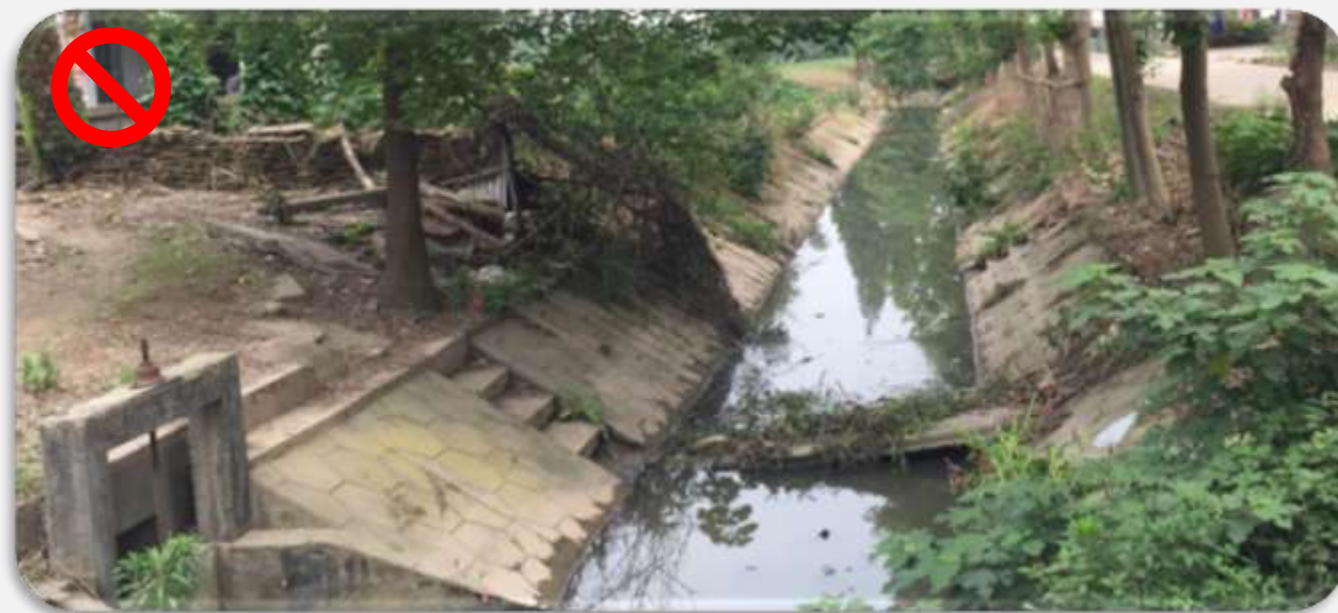
河道内的阻水构筑物
