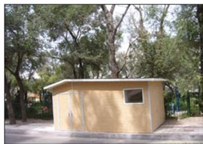
垃圾收集设施
