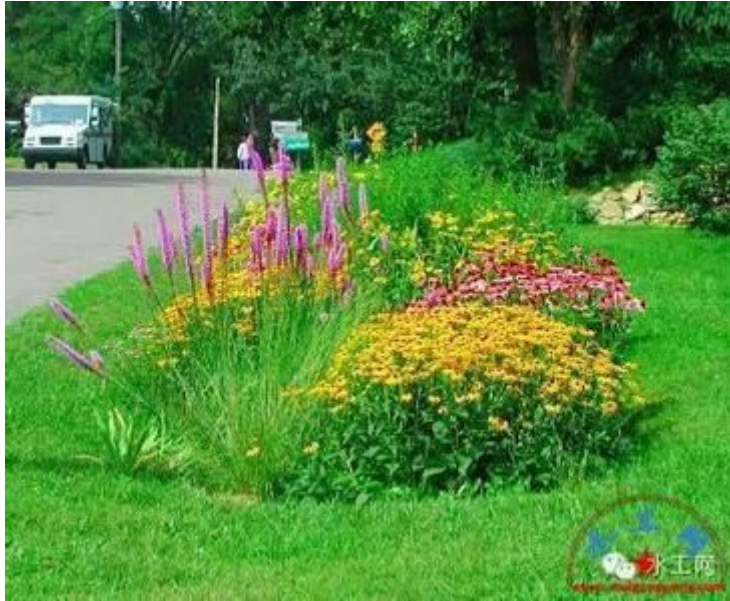
图 8.5.1 (3) -4 生物滞留设施实景图
